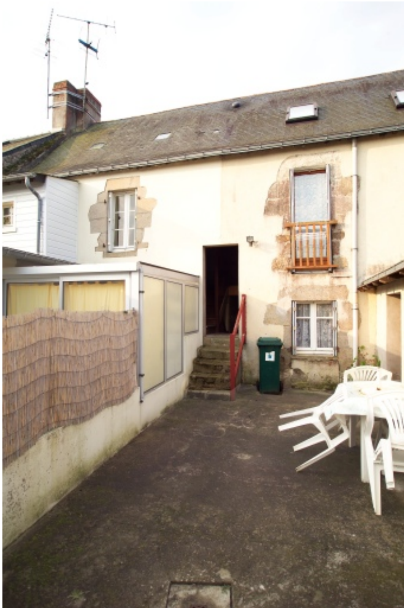
Vue de la façade arrière.
