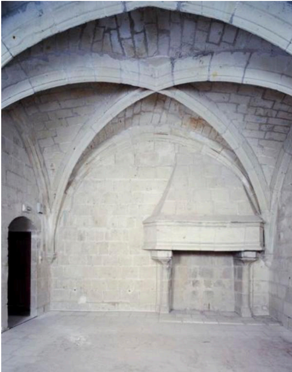
1er étage-carré : aile ouest de la tour ouest, garde-robe.
