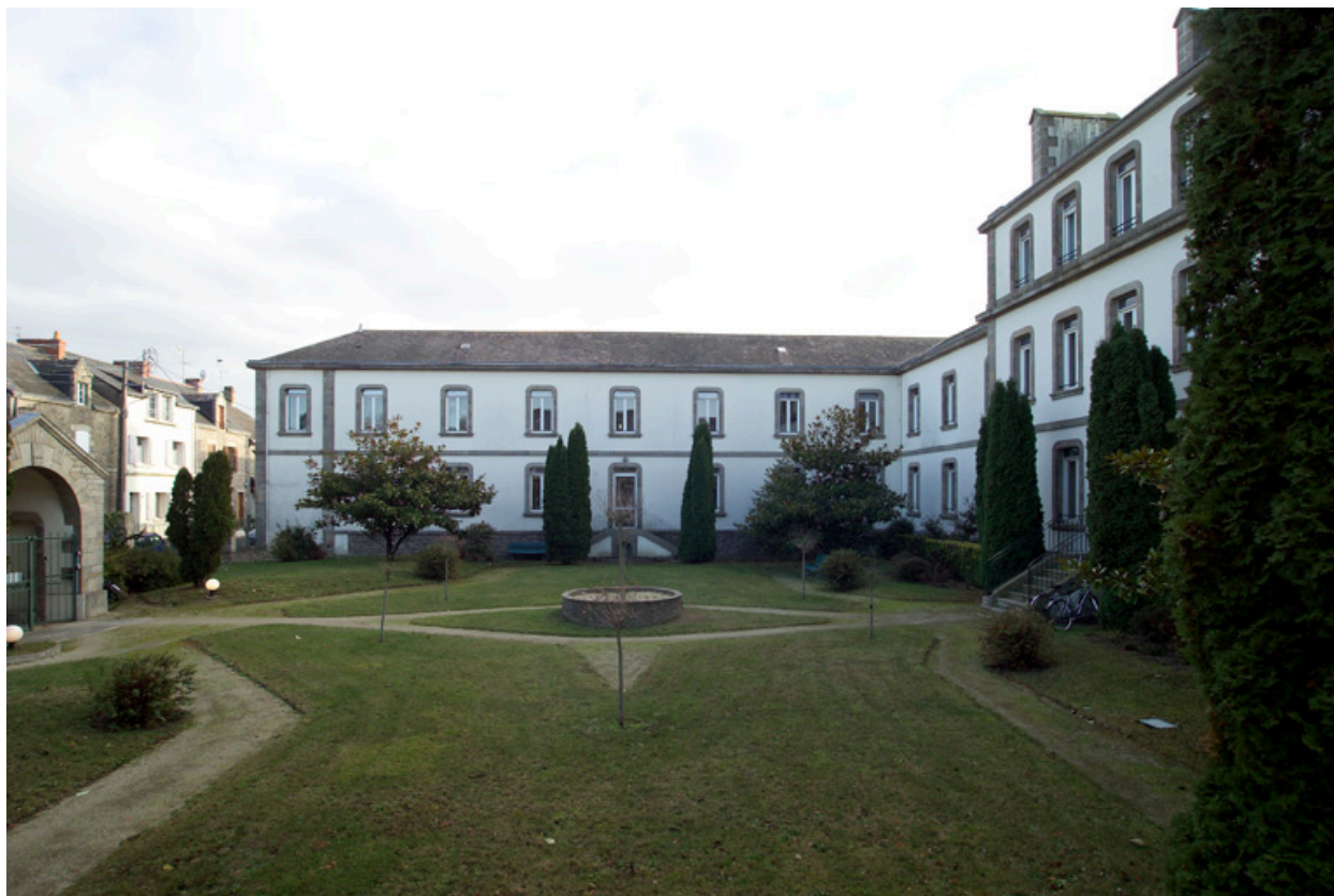
Aile orientale vue depuis l'ouest.
