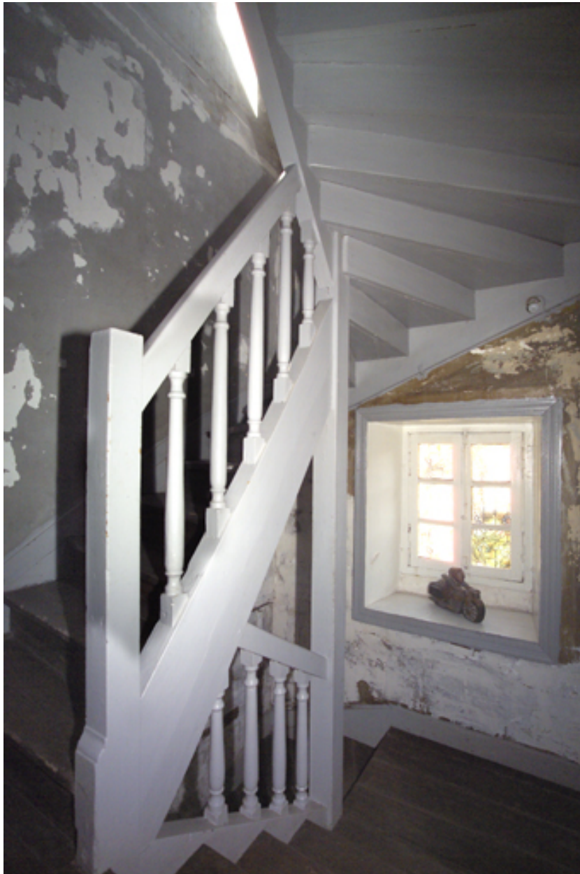
L'escalier vu depuis le palier du premier étage vers l'est.
