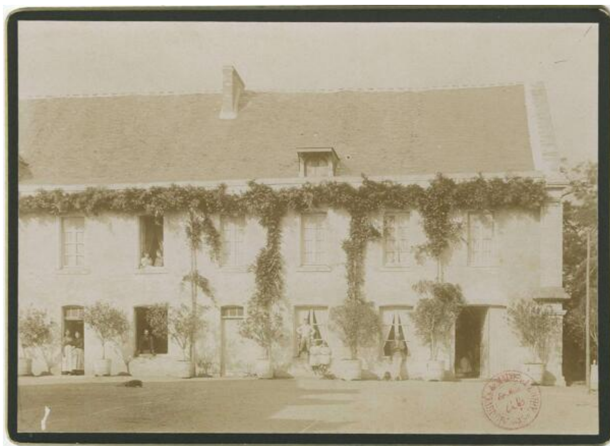
Façade sud du corps de logis principal, photographie, fin du XIXe siècle. (AD Maine-et-Loire ; 11 Fi 4598).
