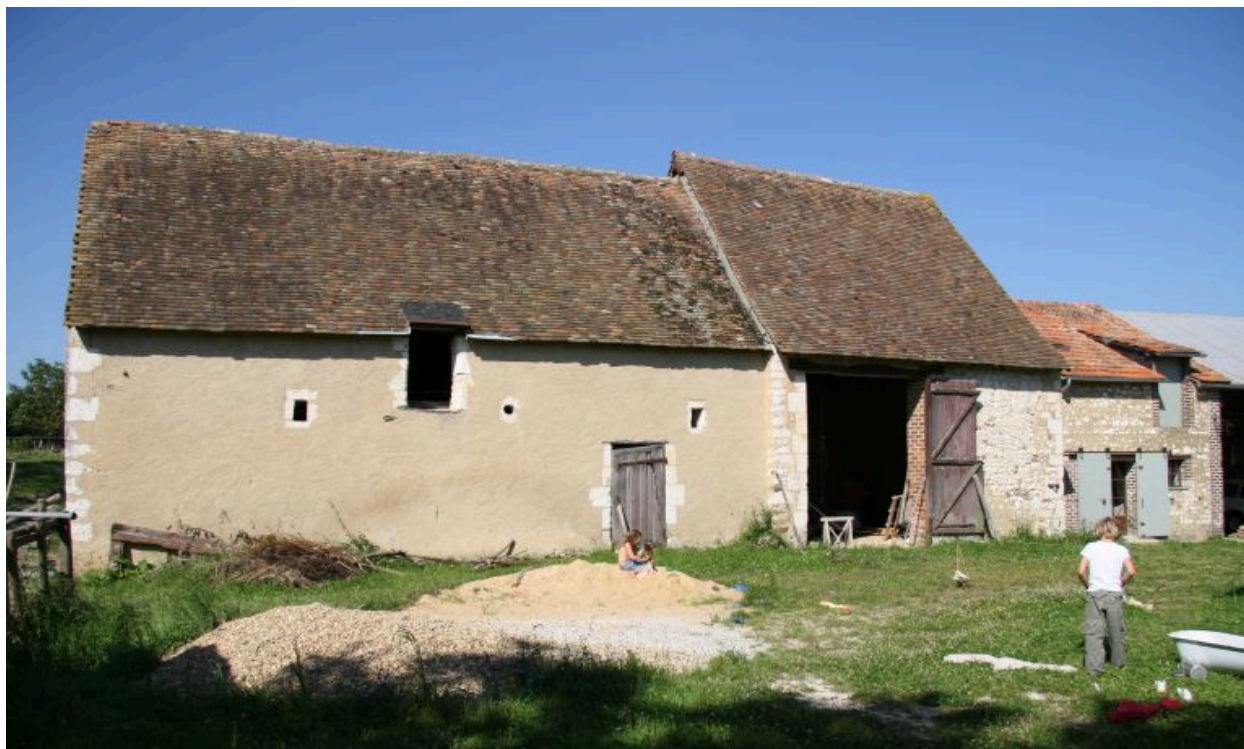
Grange-étable et écuries.
