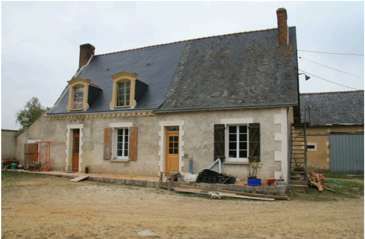
Vue d'ensemble de la maison en cours de restauration : corniche à modillons..
