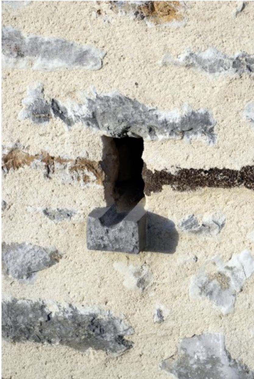
Logis, détail de la façade antérieure : ouverture d'écoulement des eaux du lavabo.
