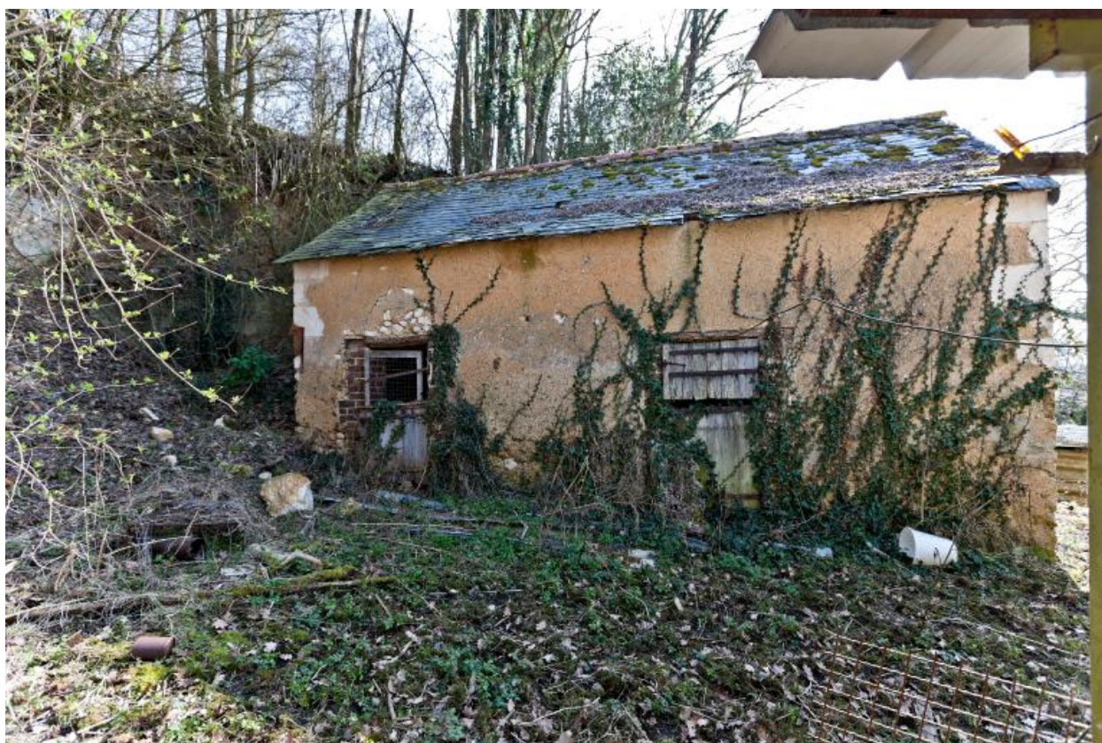
Toit à porcs, à l'arrière de la maison.
