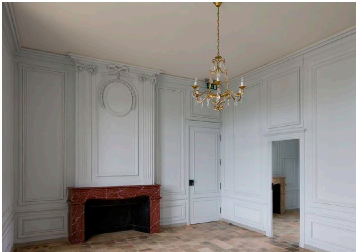
Saint-Benoît, étage-carré : logis de la Grande-prieure (après restauration).
