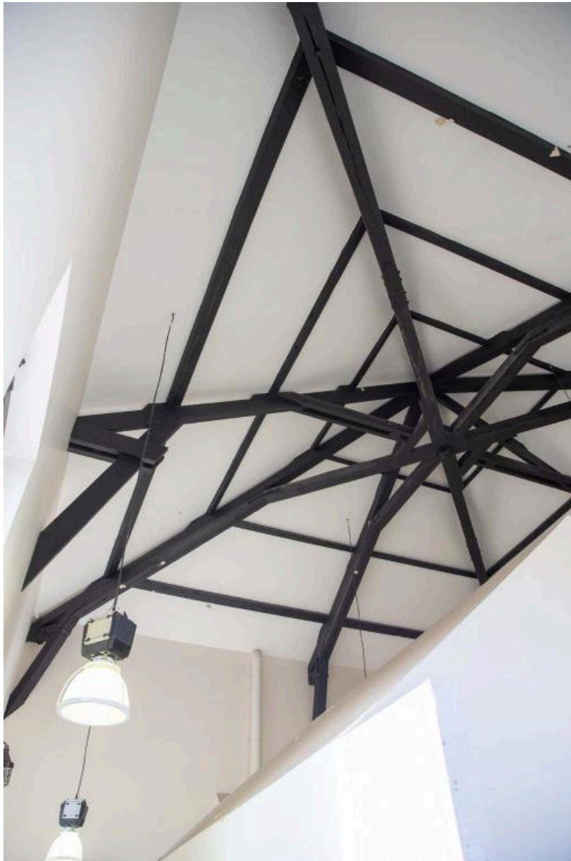
Charpente du pavillon d'entrée de la caserne.
