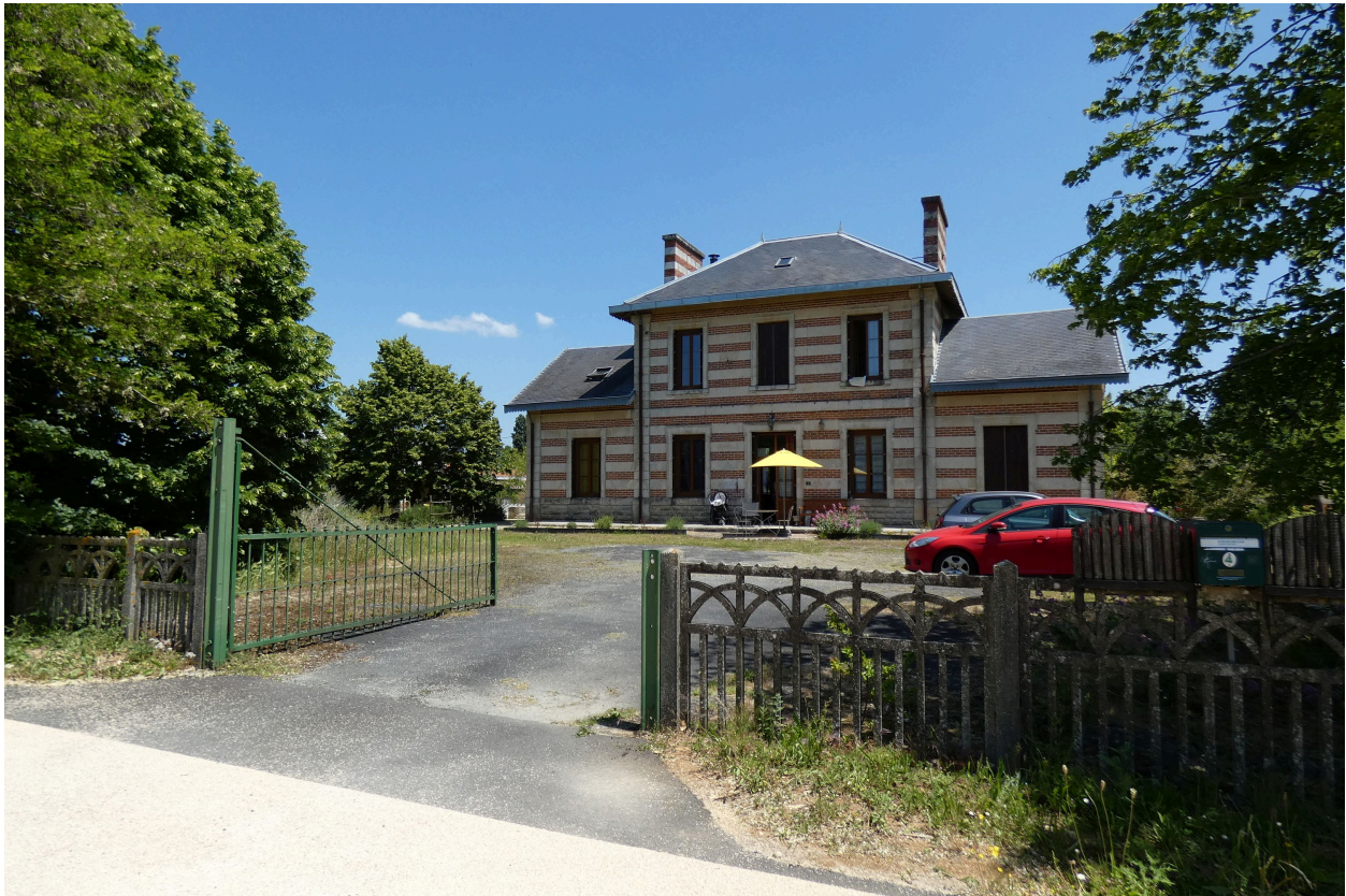
La gare vue depuis l'ouest.
