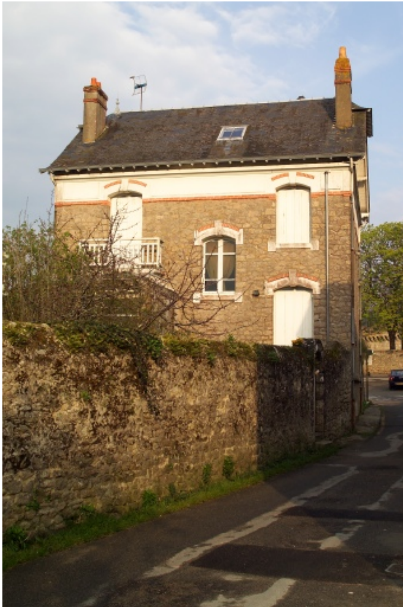
Vue de la façade arrière.
