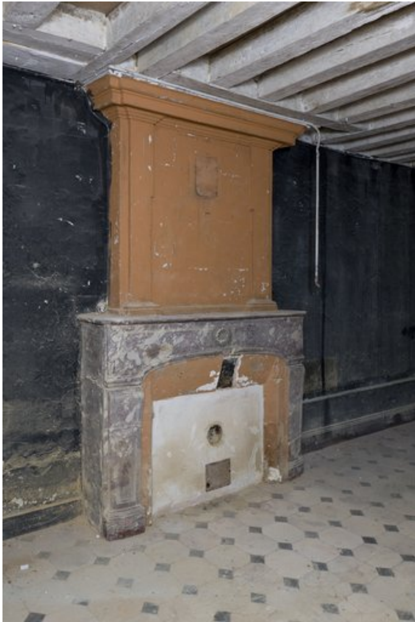
Rez-de-chaussée, ancienne salle de stockage remaniée vers 1800 en pièce à cheminée.
