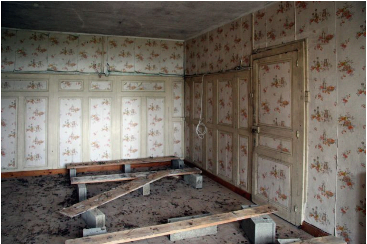
Rez-de-chaussée, salle à gauche : lambris de récupération.
