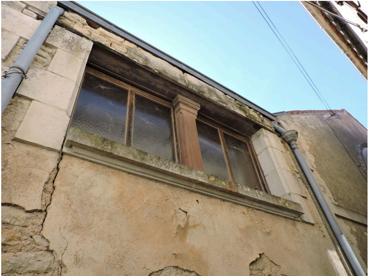
Baies jumelées sur le mur nord de l'extension de 1895.
