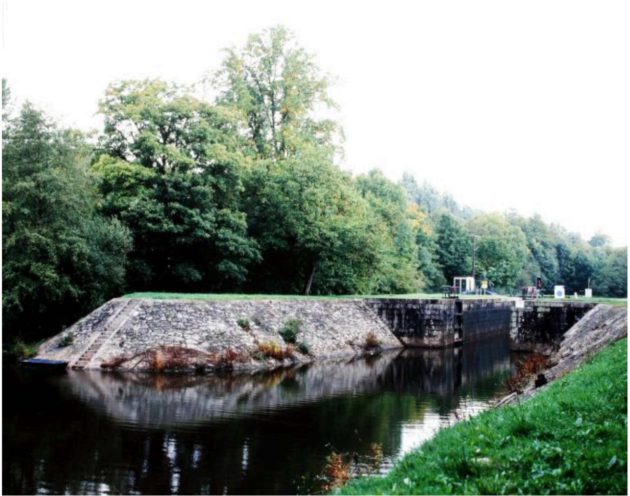
L'entrée d'aval du canal : la digue, l'écluse.
