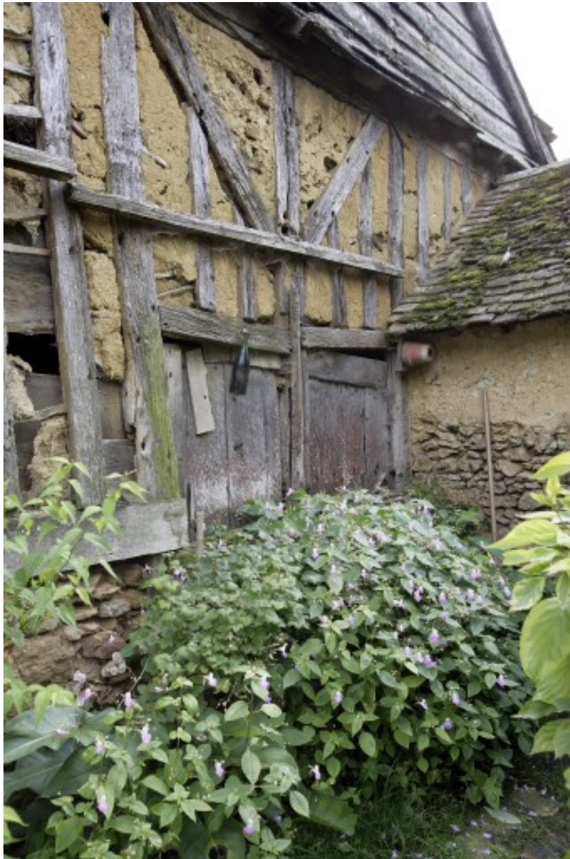
Grange-étables-remise : porte des étables dans le mur pignon nord.
