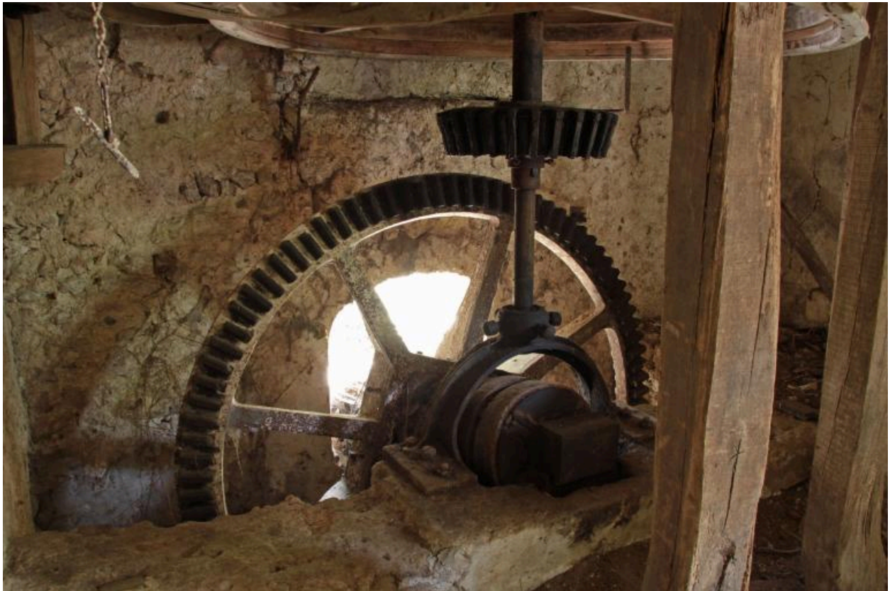
L'usine du moulin, r-d-c : détail d'un ancien mécanisme.
