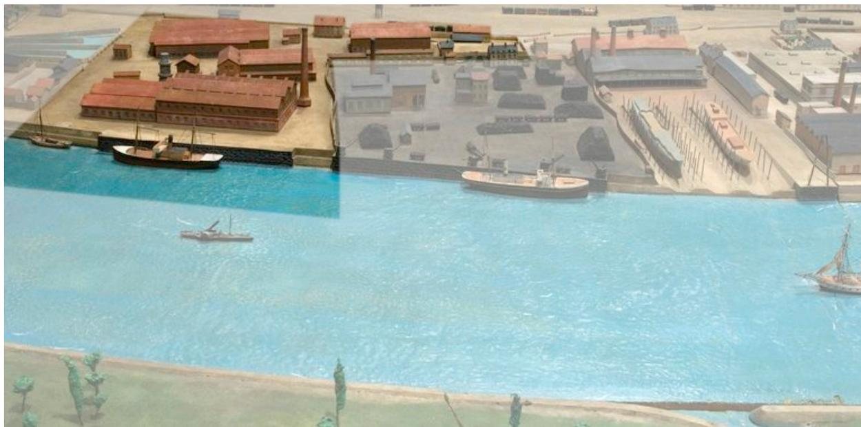
Situation de l'usine d'engrais Saint-Gobain sur la maquette réalisée pour l'Exposition Universelle de 1900 par Pierre Auguste Duchesne. On remarque la tour Gay-Lussac permettant de prévenir la libération dans l'atmosphère des oxydes d'azote.
