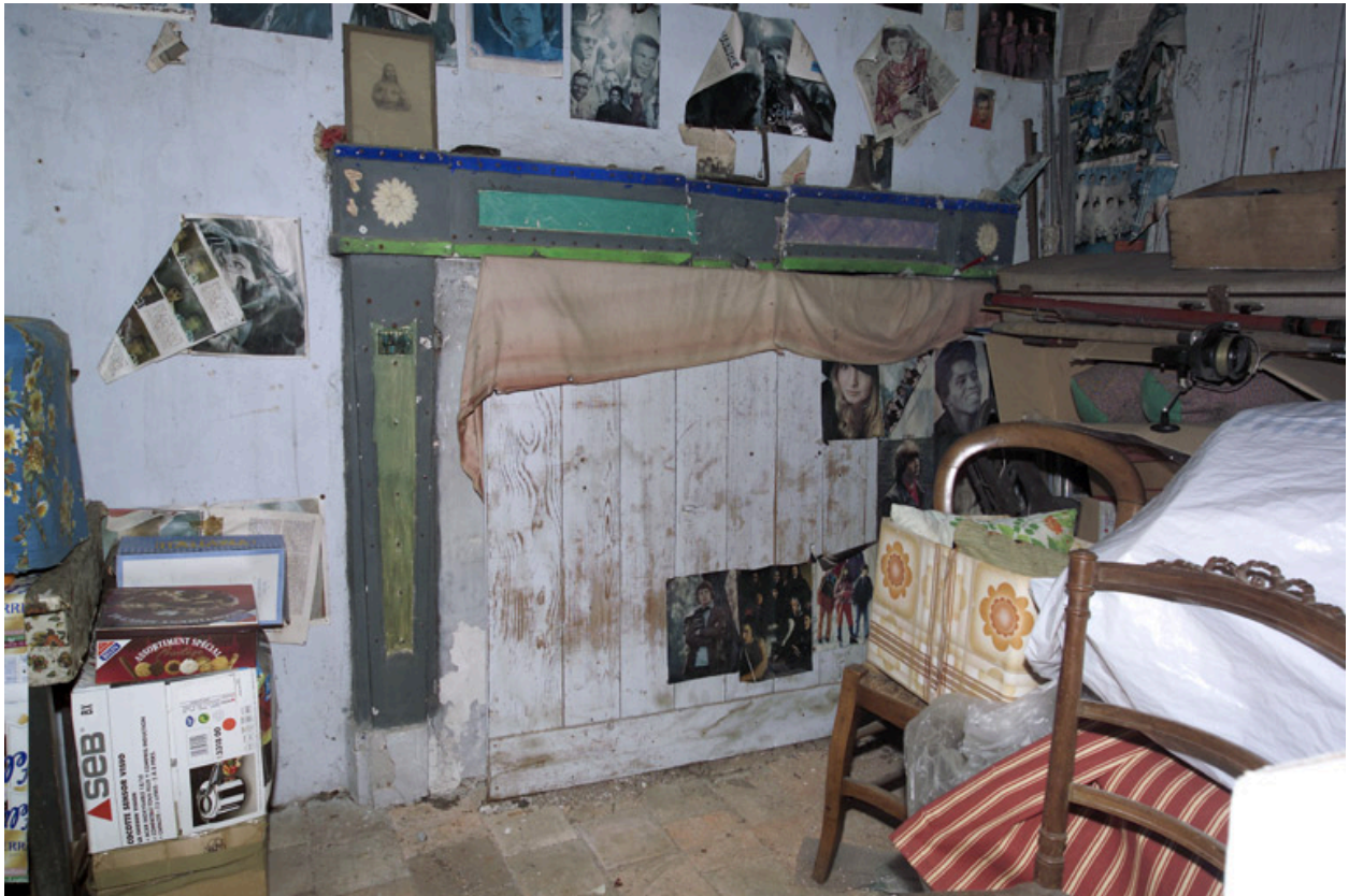
Le corps secondaire n° 5 quai Eole, premier étage, détail d'une cheminée.
