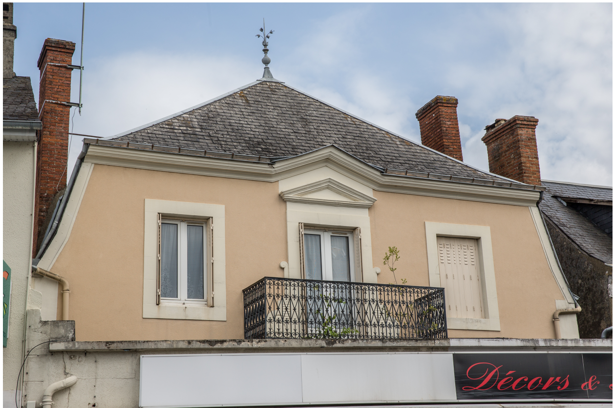
Un détail de maison de la place.
