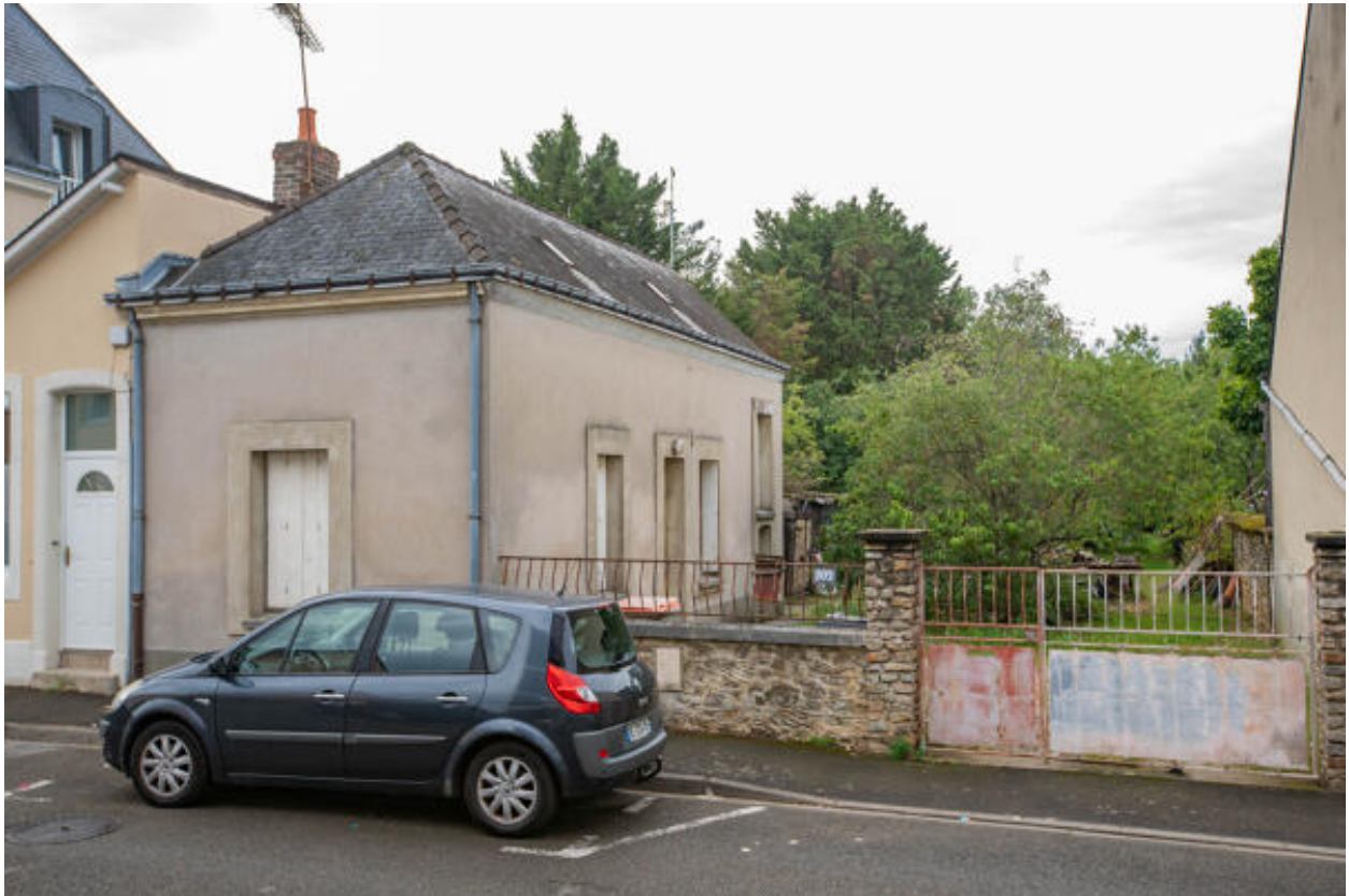
Vue d'une maison, pignon donnant sur la rue, rue des Charmes.
