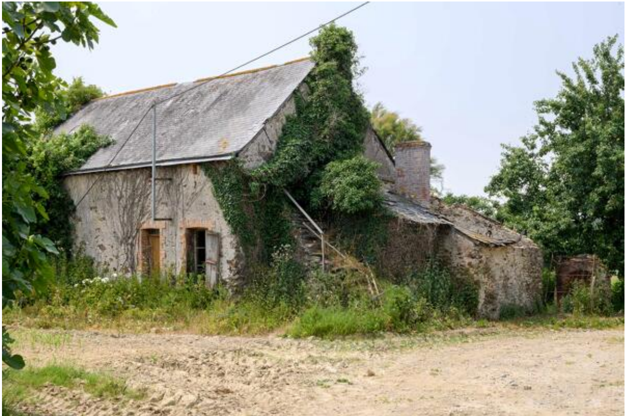
Vue du logis depuis l'est.
