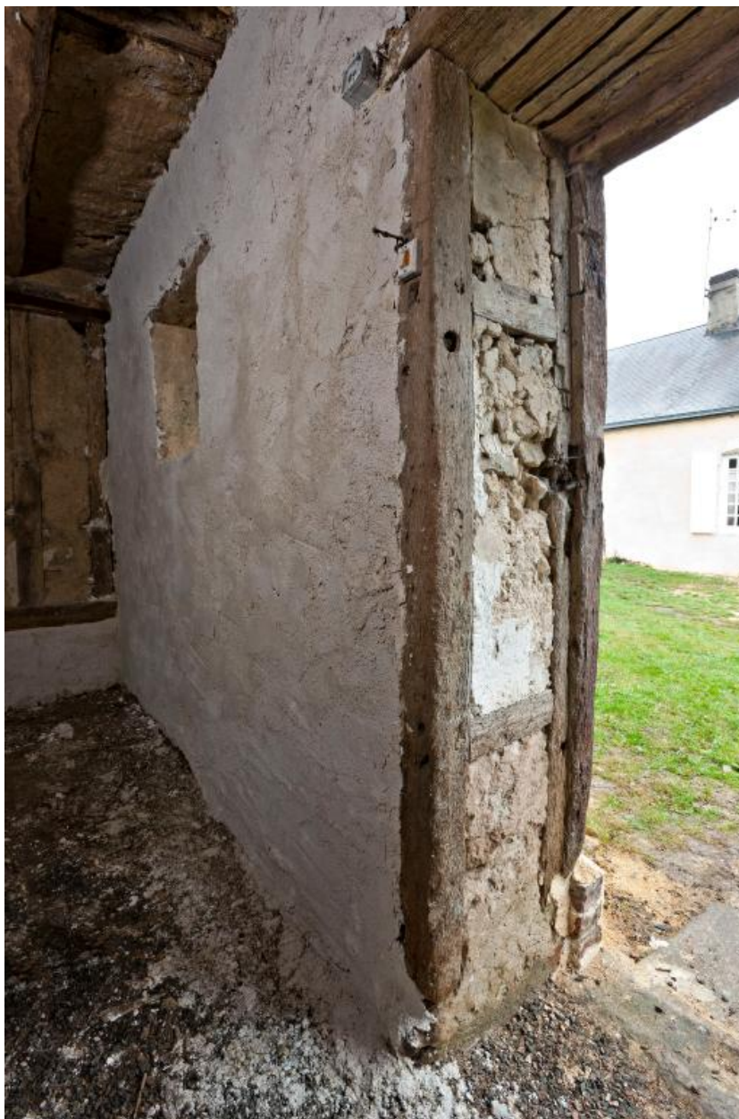
Dépendance : détail d'une entrée.
