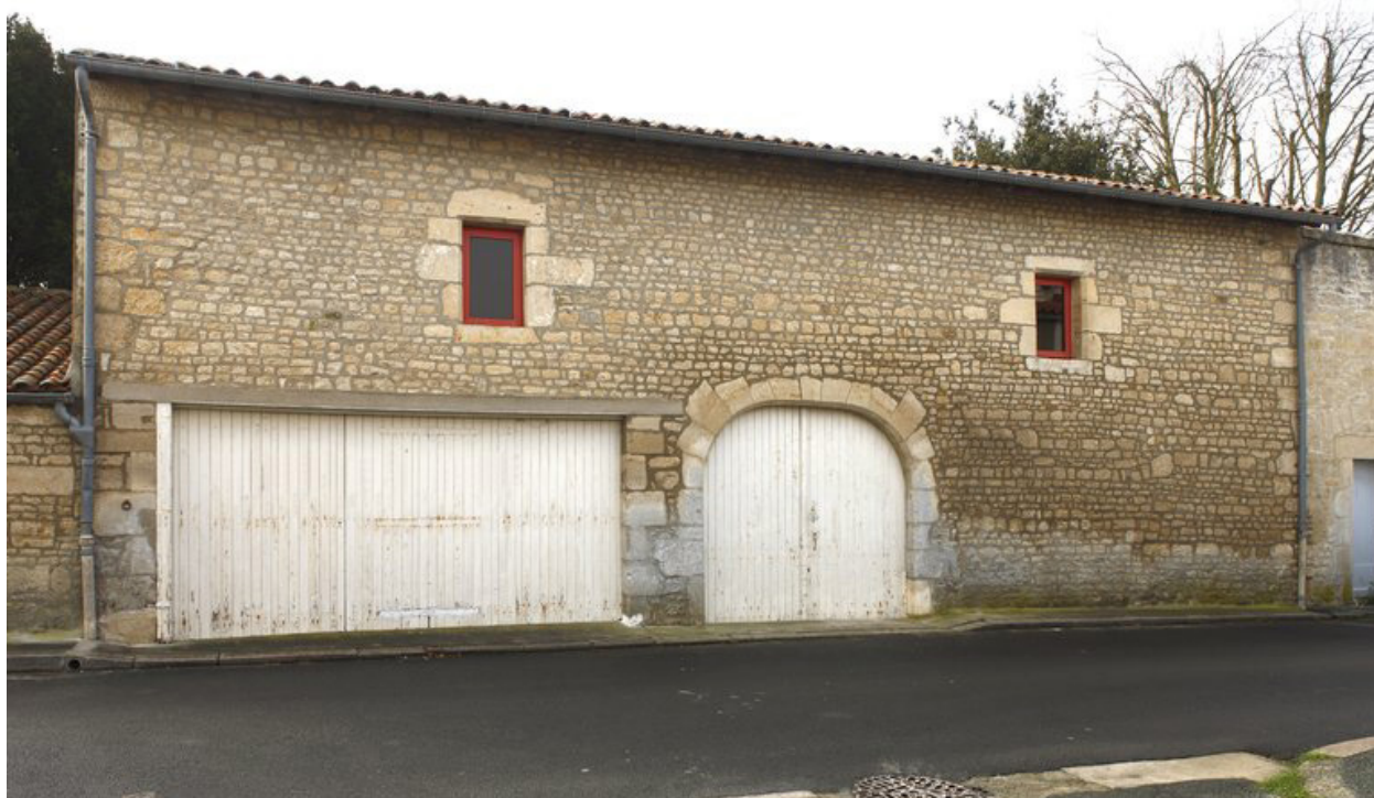
Façade des communs, au nord du n° 21, donnant sur la rue Emile-Zola.
