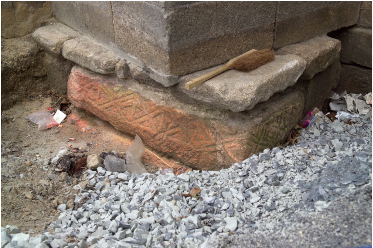
Elément lapidaire réemployé dans les fondations d'un contrefort sur le mur nord (fouilles archéologiques de 2006).
