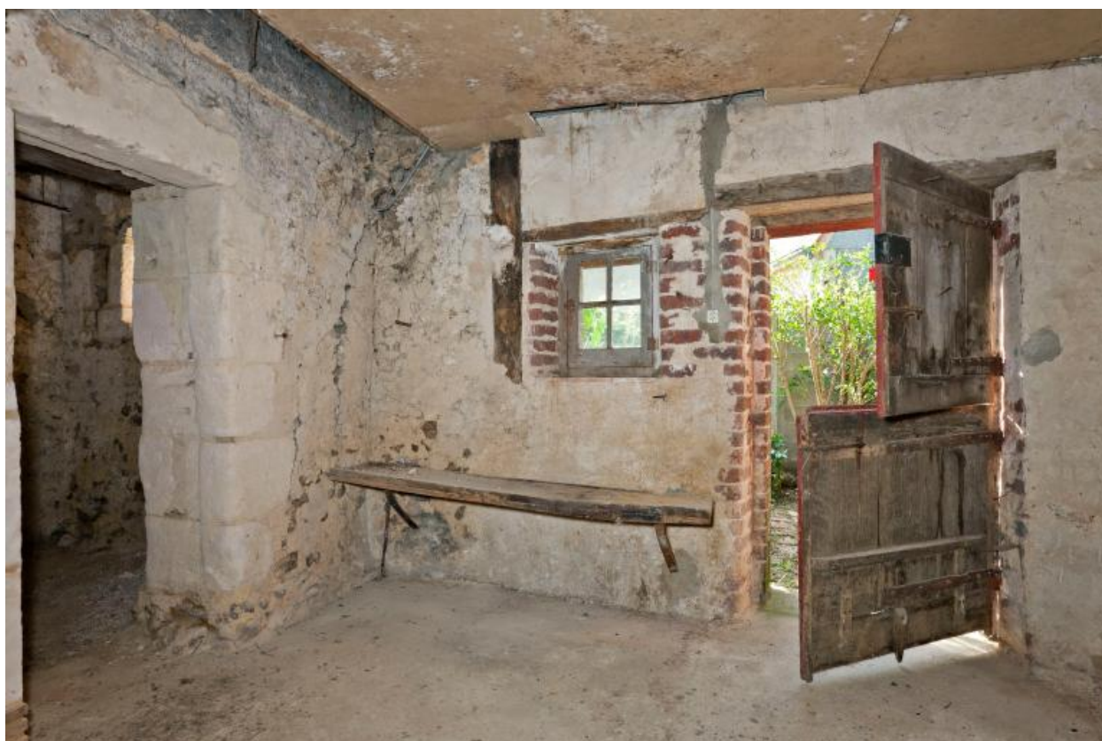
Maison 2 : pièce à feu.
