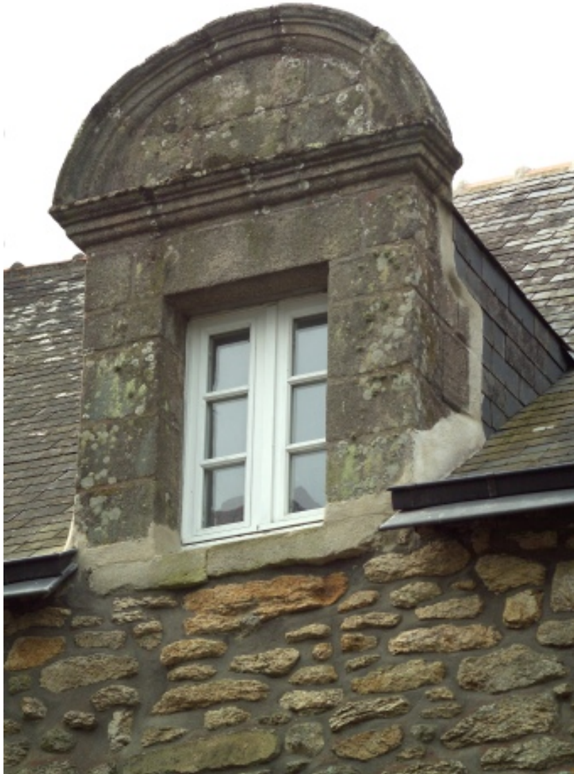
Détail de la lucarne est de la façade sur rue.
