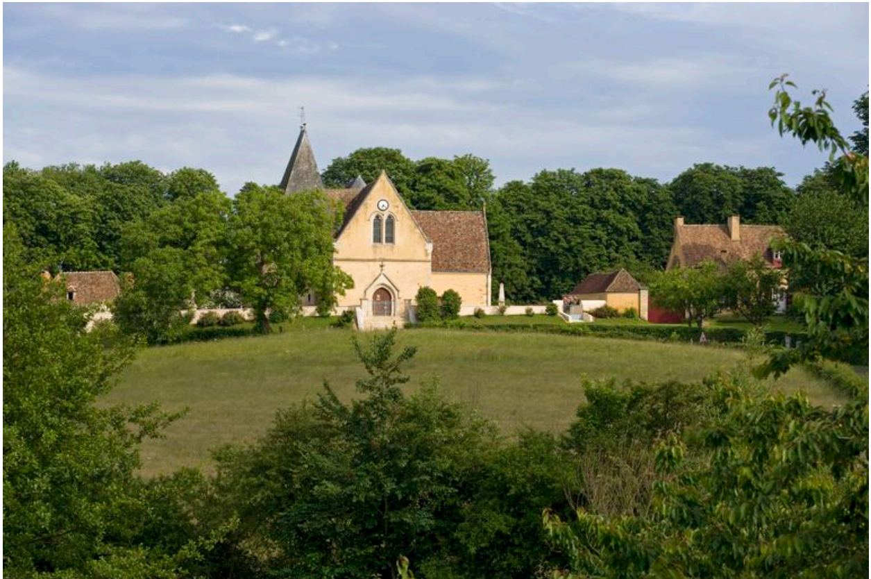
Vue générale du bourg ancien depuis l'ouest.
