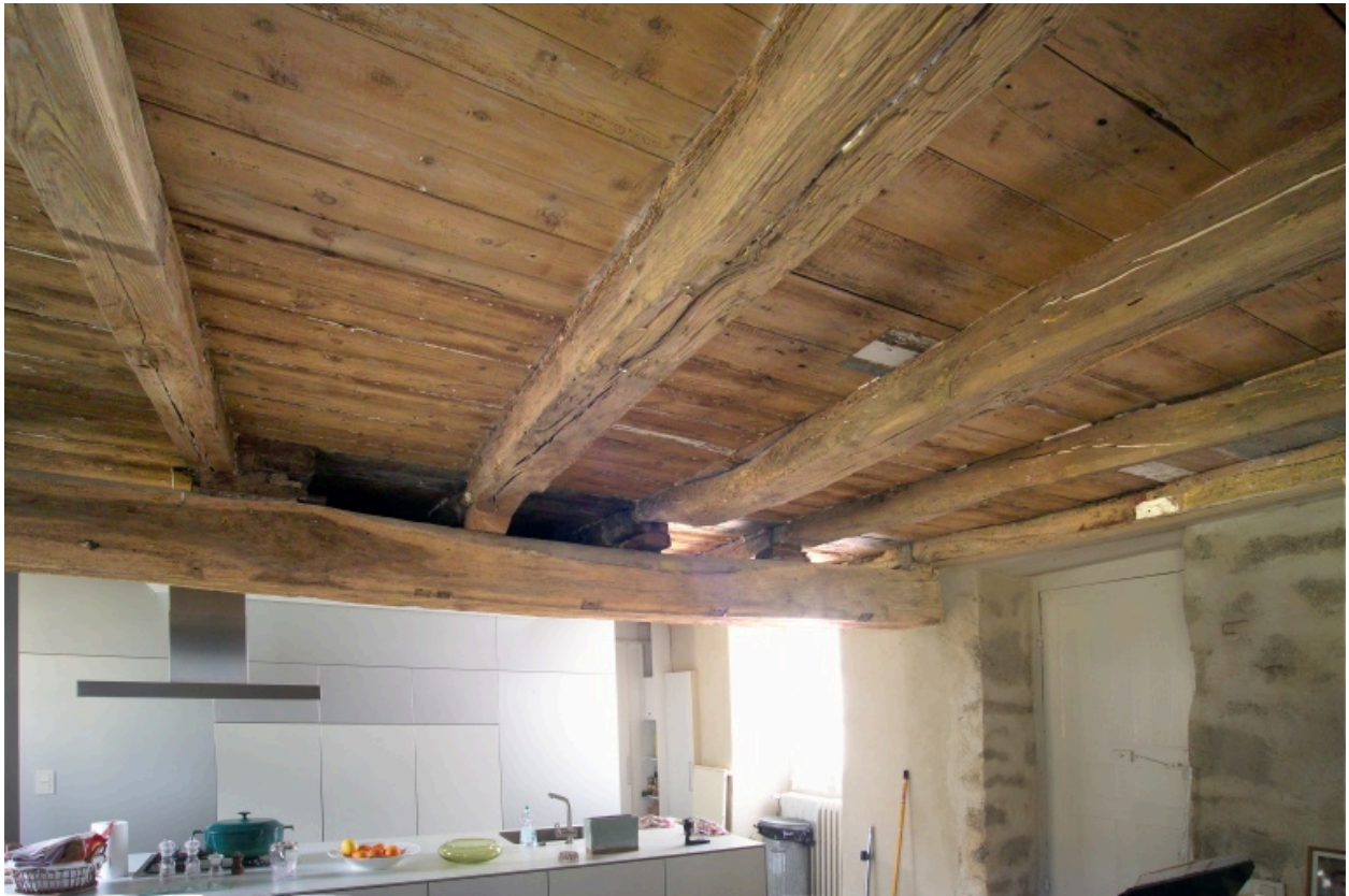
Plafond du rez-de-chaussée du corps sud.
