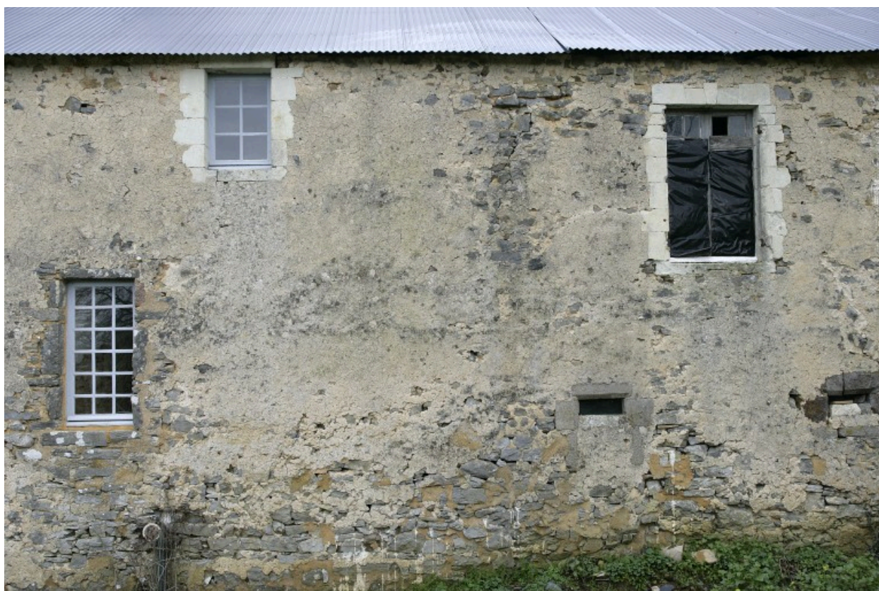
Le logis manorial, détail de l'élévation postérieure : partie nord.
