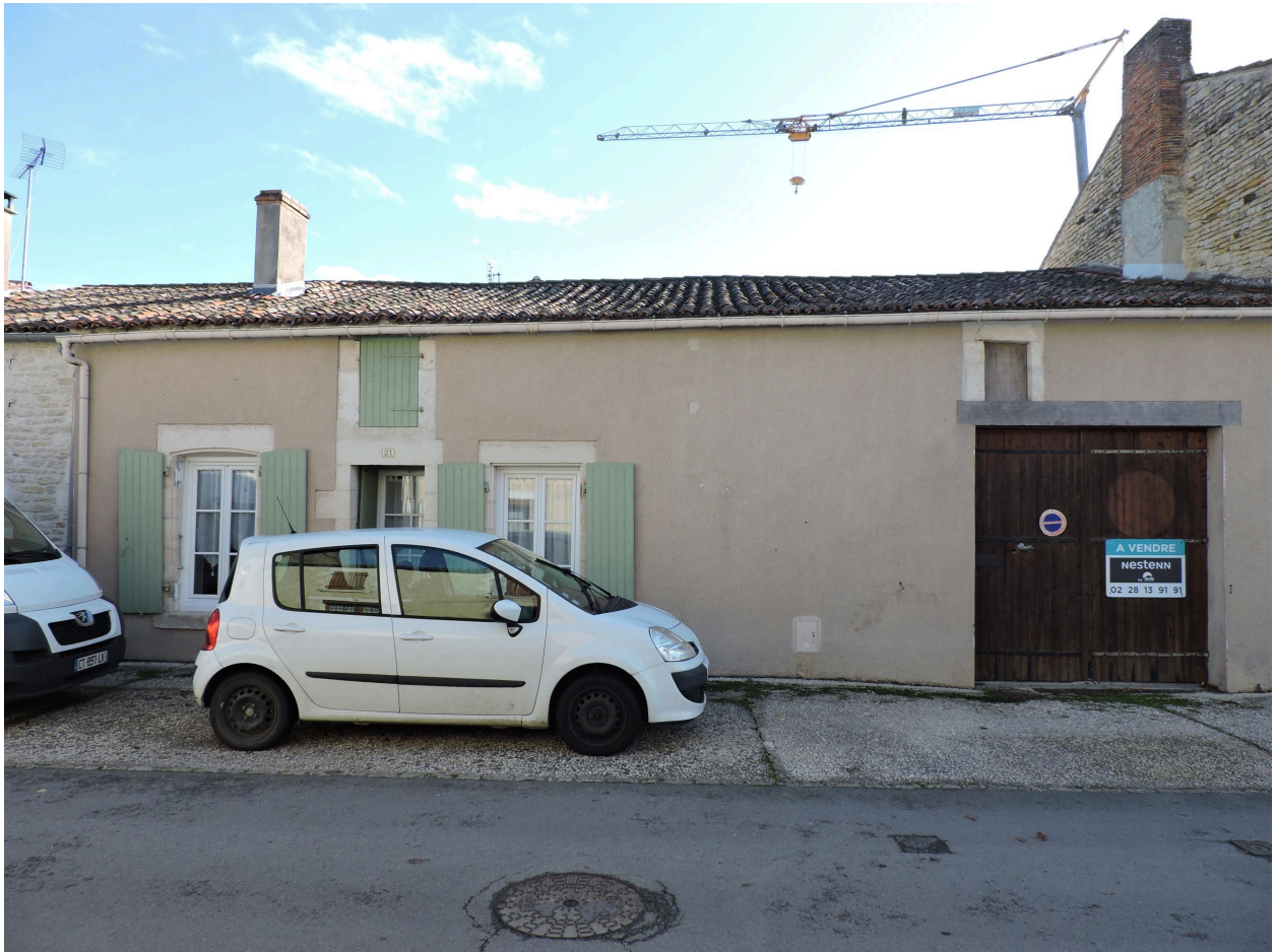
Vue depuis le nord.
