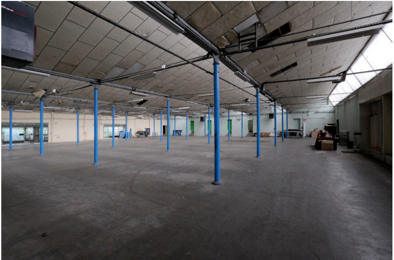
Vue intérieure de l'usine Durand-Chéné.
