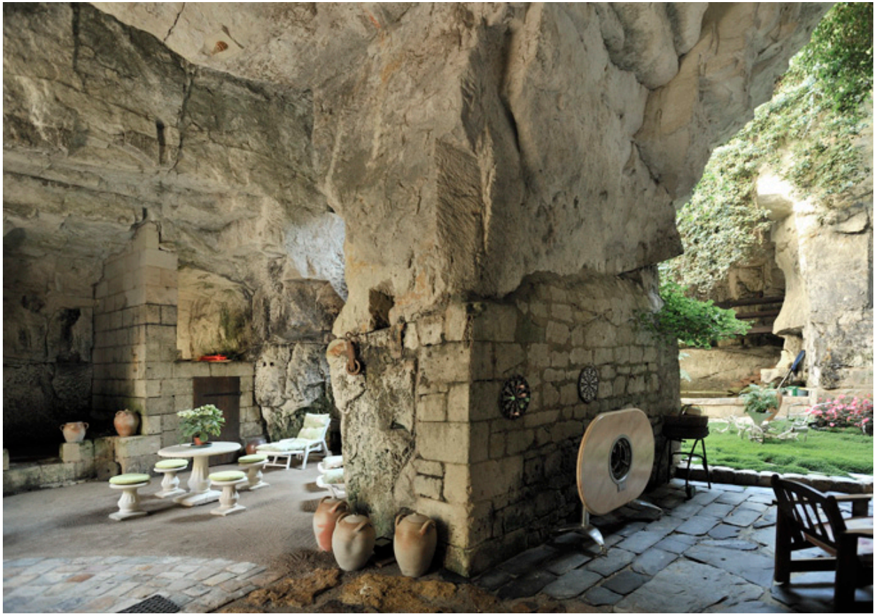
Pilier tourné avec confortement maçonné.
