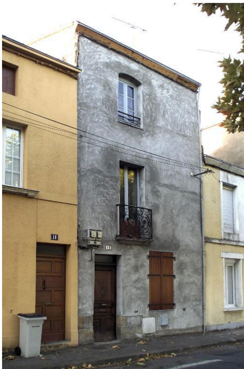
La façade antérieure de la maison n° 12 quai Gautreau.
