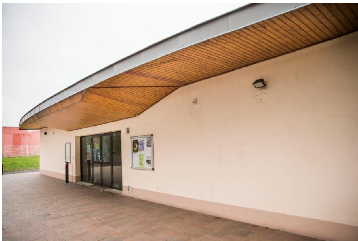
Vue de l'entrée de la maison de quartier des Sablons.
