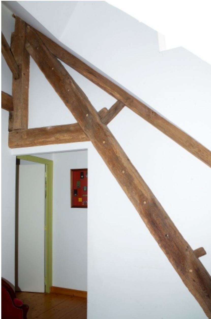
Détail de la charpente de la maison.
