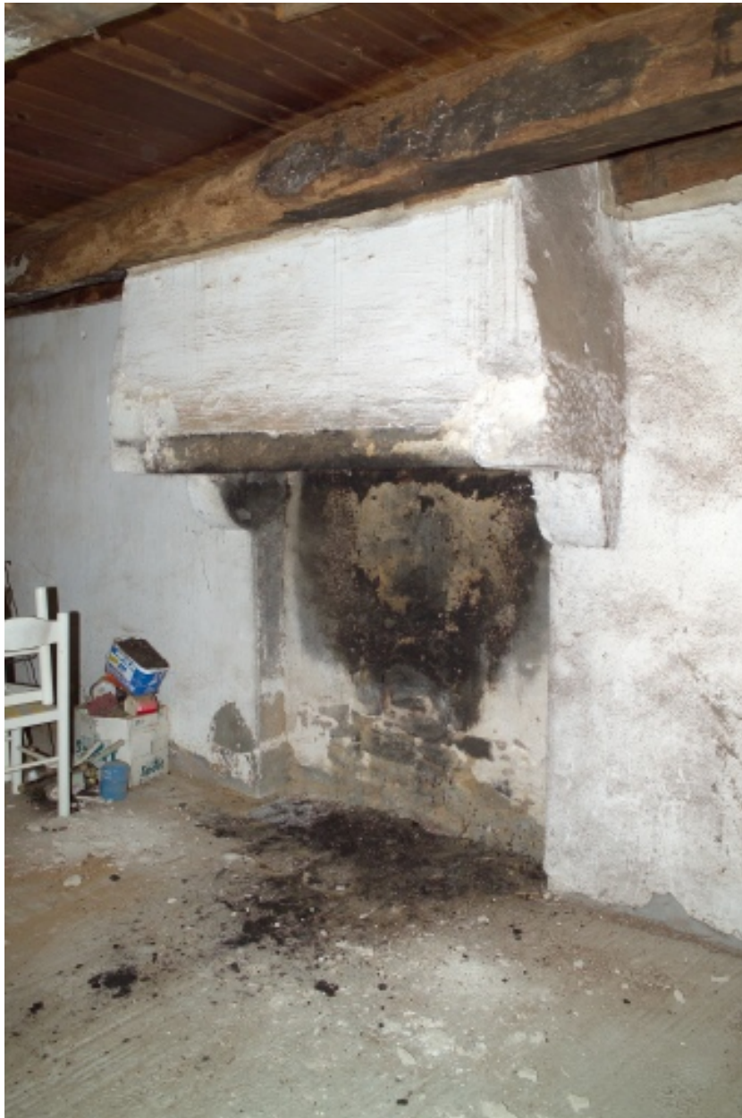
Cheminée au premier étage.
