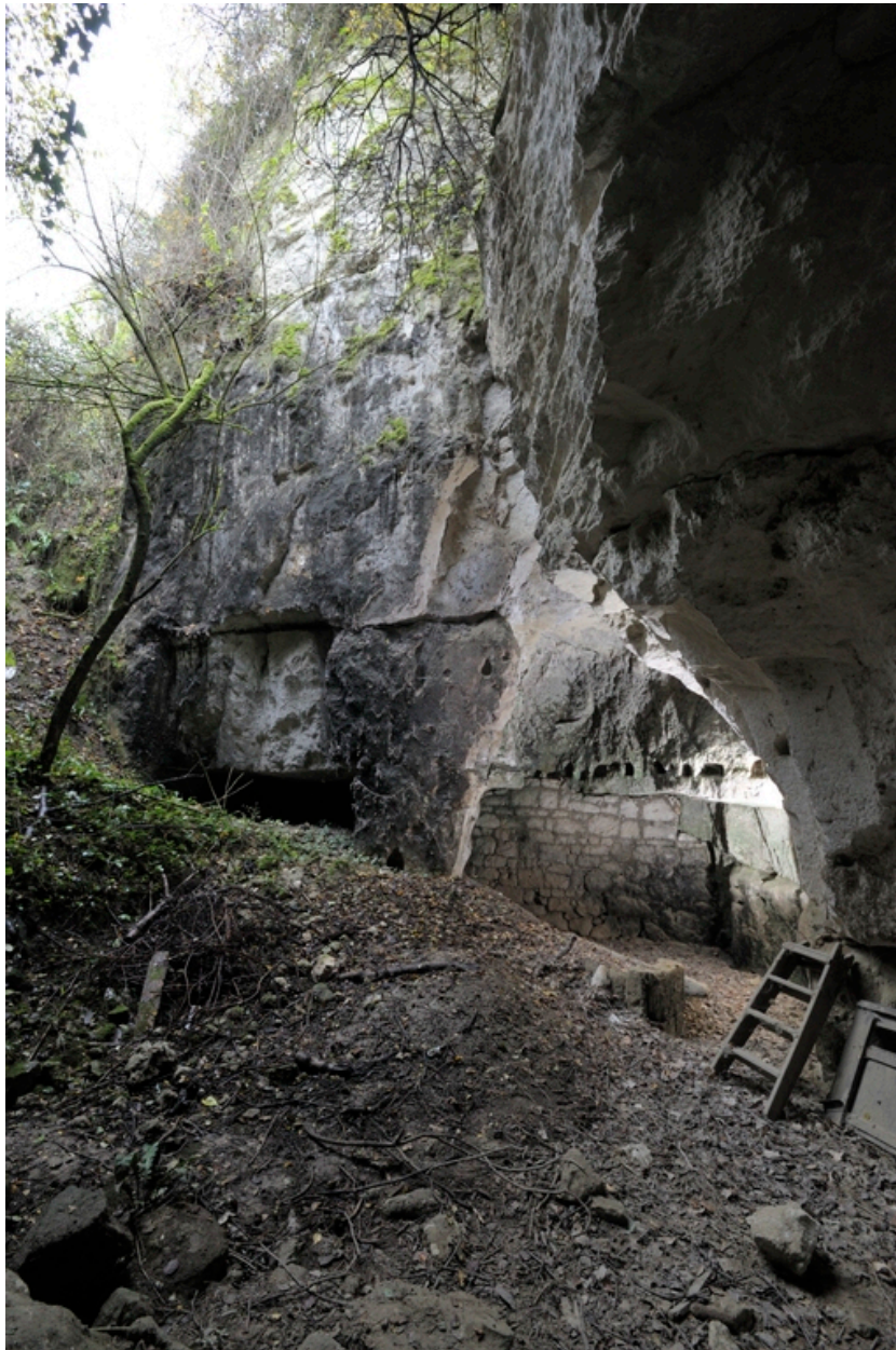
Fontis en partie postérieure de l'abri troglodytique. Anciennes dépendances agricoles (2).
