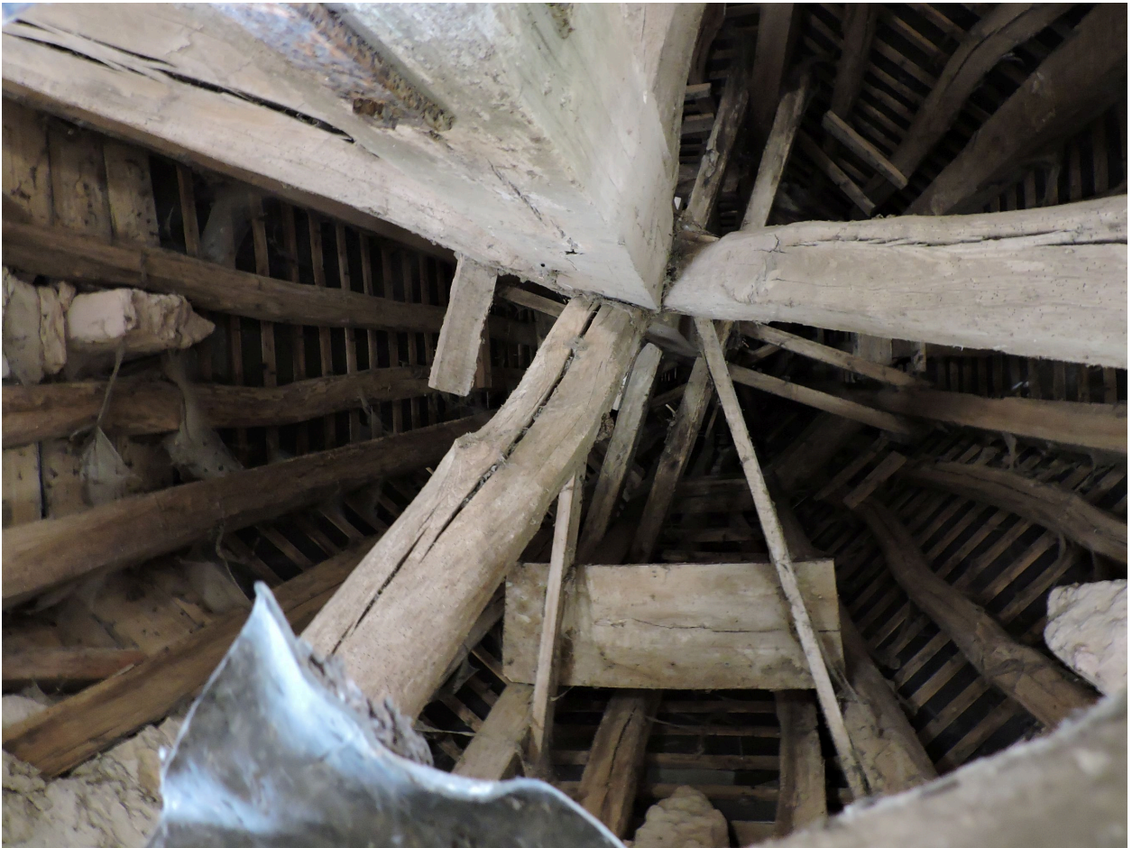
La charpente du clocher.
