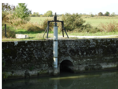
La bonde côté amont, du côté de la ceinture des Hollandais, vue depuis le nord. Phot. Yannis Suire IVR52_20188500356NUCA
