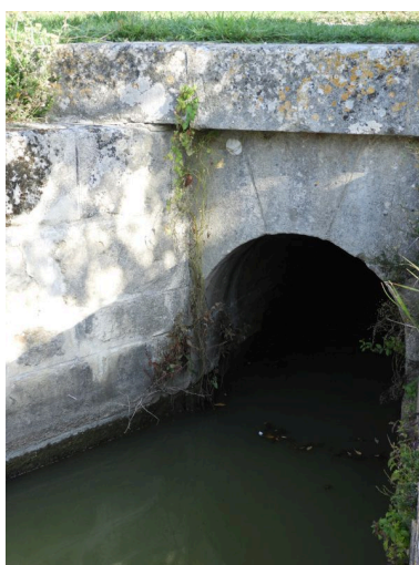
Le passage voûté de la bonde, côté aval, au sud. Phot. Yannis Suire IVR52_20188500366NUCA
