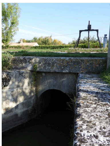
Le passage voûté de la bonde, côté aval, au sud, et le portique au-dessus de la vanne, en arrière. Phot. Yannis Suire IVR52_20188500367NUCA
