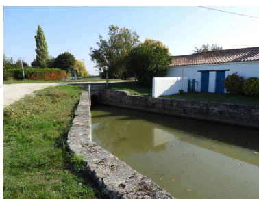
La bonde côté aval, les quais qui l'encadrent et l'ancienne maison de garde, vus depuis le sud-ouest. Phot. Yannis Suire IVR52_20188500363NUCA
