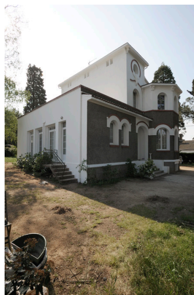
Maison d'Eugène Hy : vue depuis le nord. Phot. Bruno Rousseau, Phot. Youenn Communeau IVR52_20114901311NUCA
