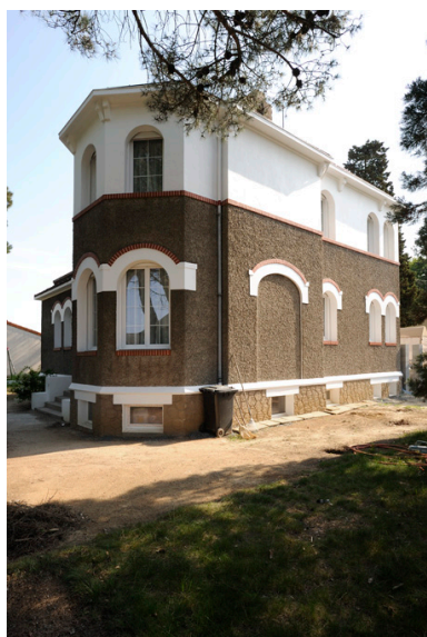
Maison d'Eugène Hy : vue depuis sud-ouest. Phot. Bruno Rousseau, Phot. Youenn Communeau IVR52_20114901313NUCA
