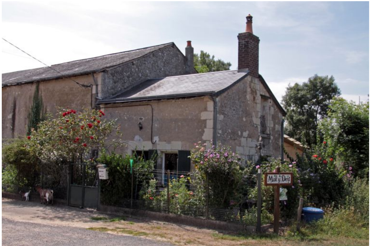
Ferme du moulin, bâtiment d'habitation et dépendances : détail.
