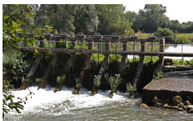
Le barrage de Malidor. Phot. Jean-Baptiste Darrasse IVR52_20097200650NUCA
