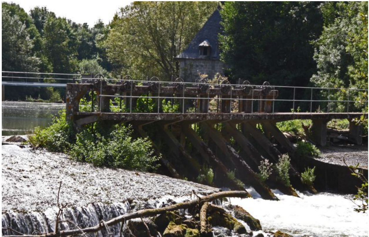
Le moulin de Malidor et le barrage.
