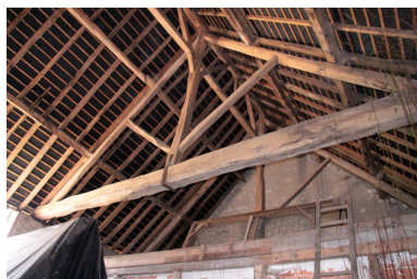
ferme du moulin, grange : charpente. Phot. Jean-Baptiste Darrasse IVR52_20097200644NUCA
