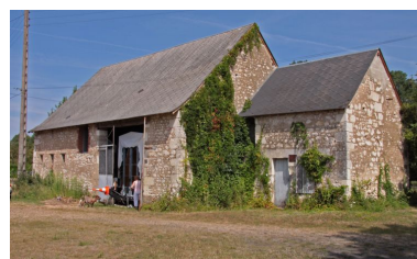
ferme du moulin : la grange (début du XIXe siècle). Phot. Jean-Baptiste Darrasse IVR52_20097200643NUCA
