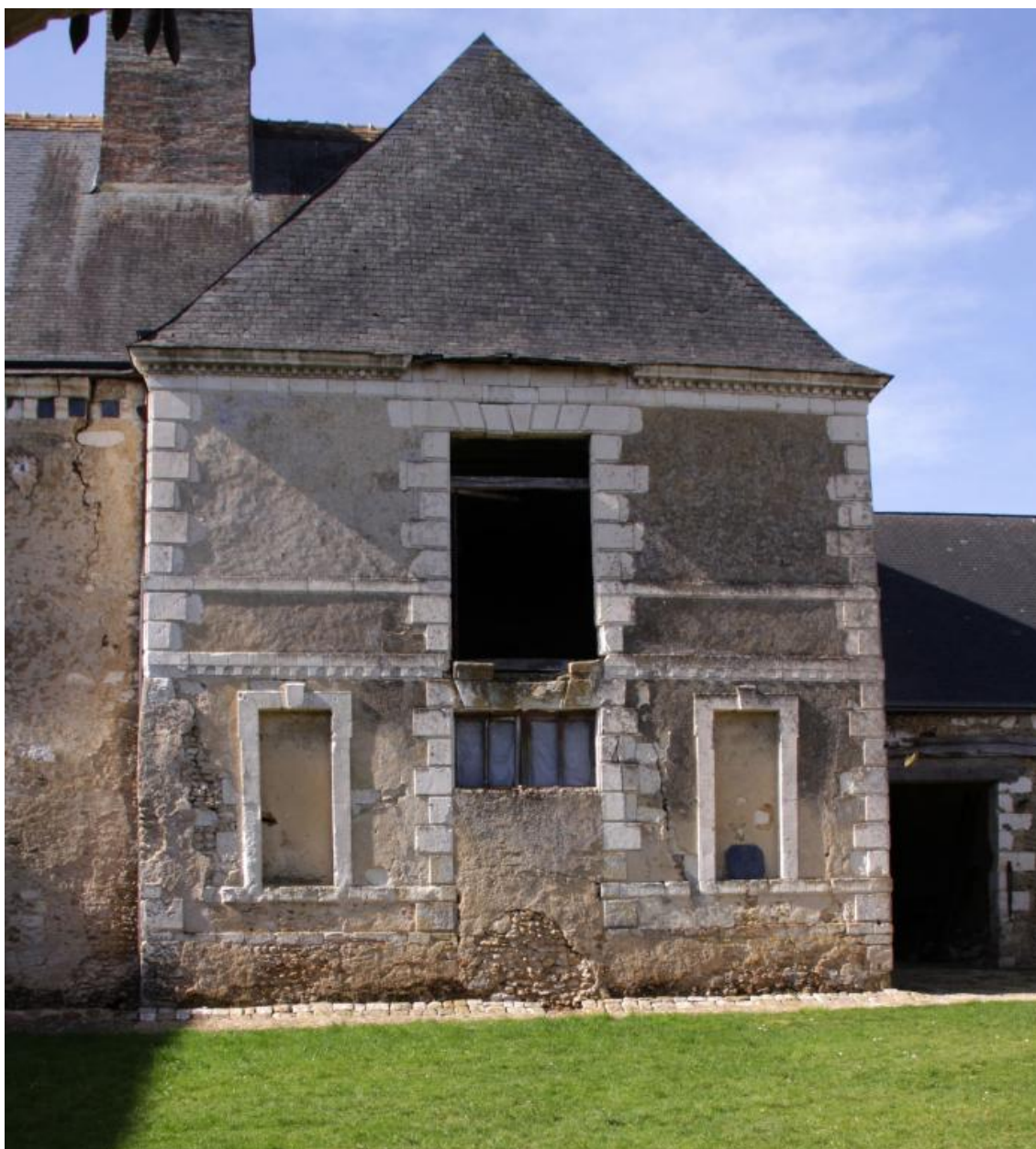
Pavillon XVIIe, façade sur cour.
