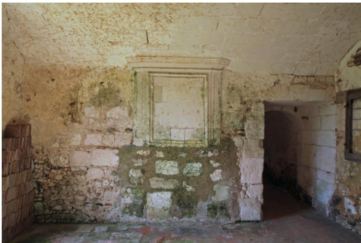
Pavillon, r-d-c côté jardin : pièce voûtée (sud).
