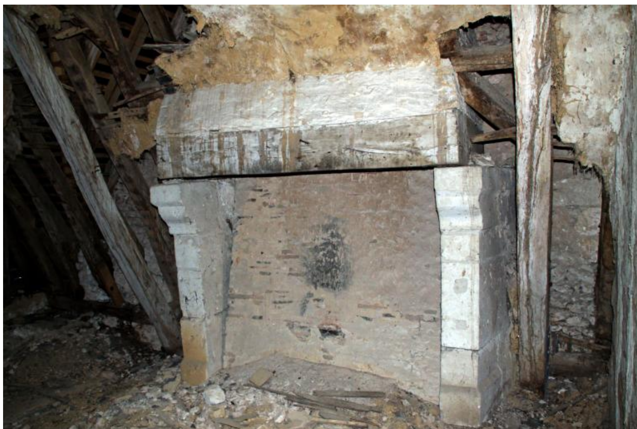
Comble du corps central : cheminée.
