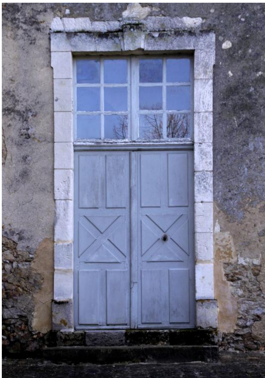
Corps central, façade sur cour : porte d'entrée.
