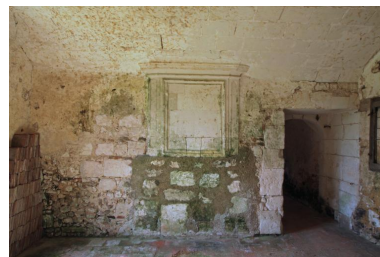
Pavillon, r-d-c côté jardin : pièce voûtée (sud).
