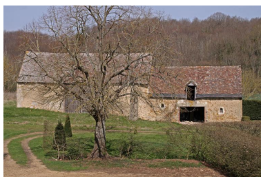
Grange et étable. Phot. Jean-Baptiste Darrasse IVR52_20107200428NUCA
