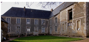
Façades sur cour. Phot. Jean-Baptiste Darrasse IVR52_20107200460NUCA
