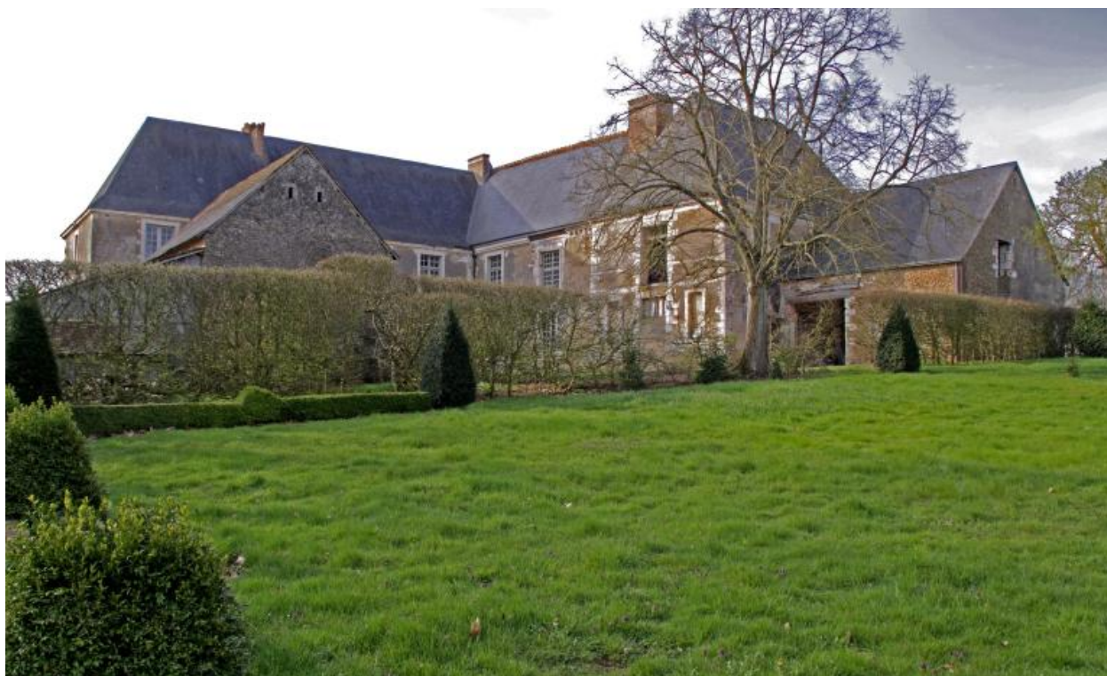
Vue générale prise depuis le nord.
