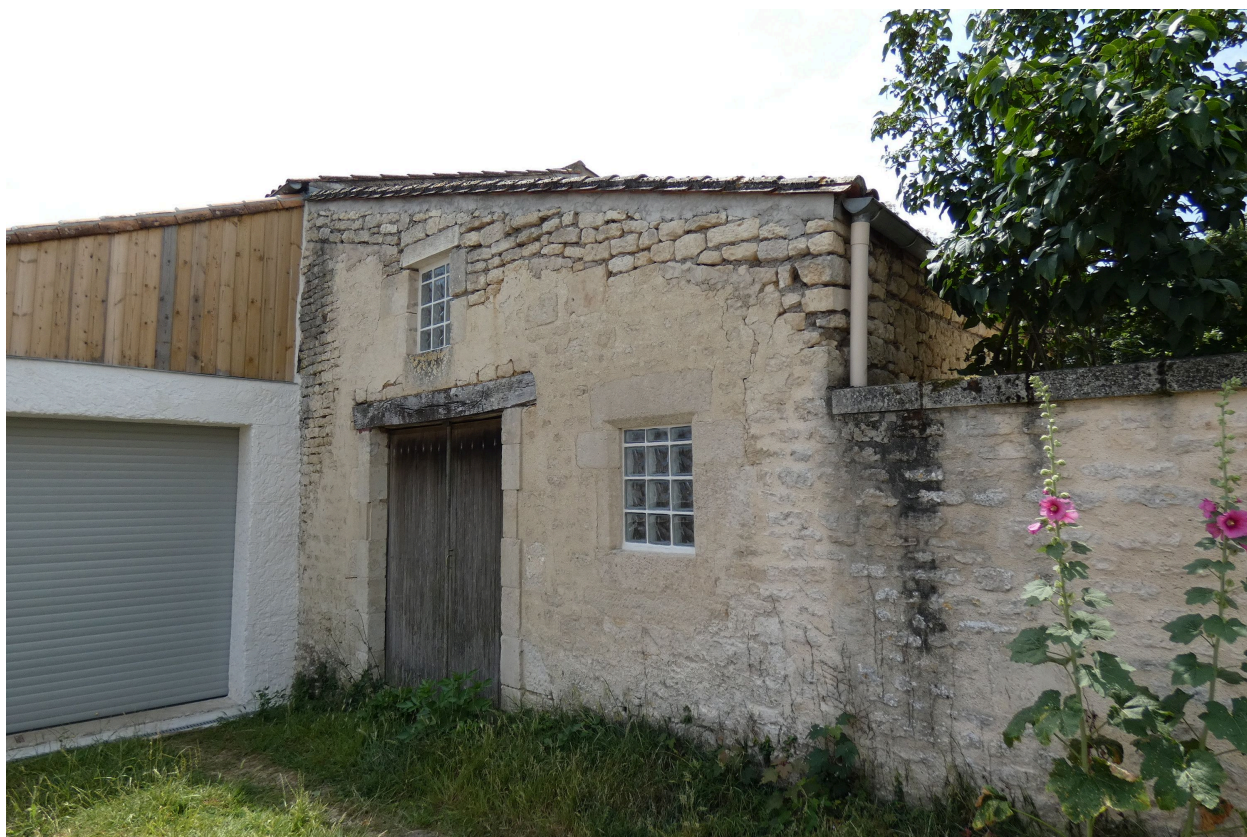
Une partie des communs à l'est de la cour, vue depuis le nord-ouest.
