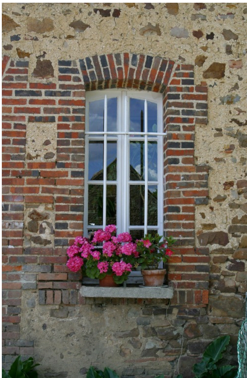
Détail de la façade du logis : fenêtre.
