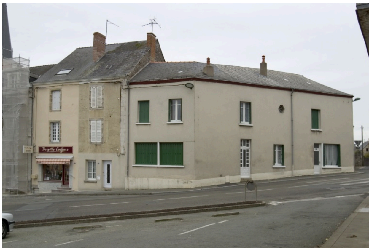
Vue depuis la place. La maison est à gauche.
