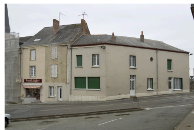
Vue depuis la place. La maison est à gauche. Phot. François Lasa IVR52_20045303265NUCA
