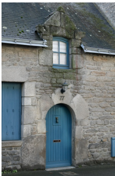
Façade sur rue, détail de la travée centrale. Phot. Denis Pillet IVR52_20064403091NUCA
