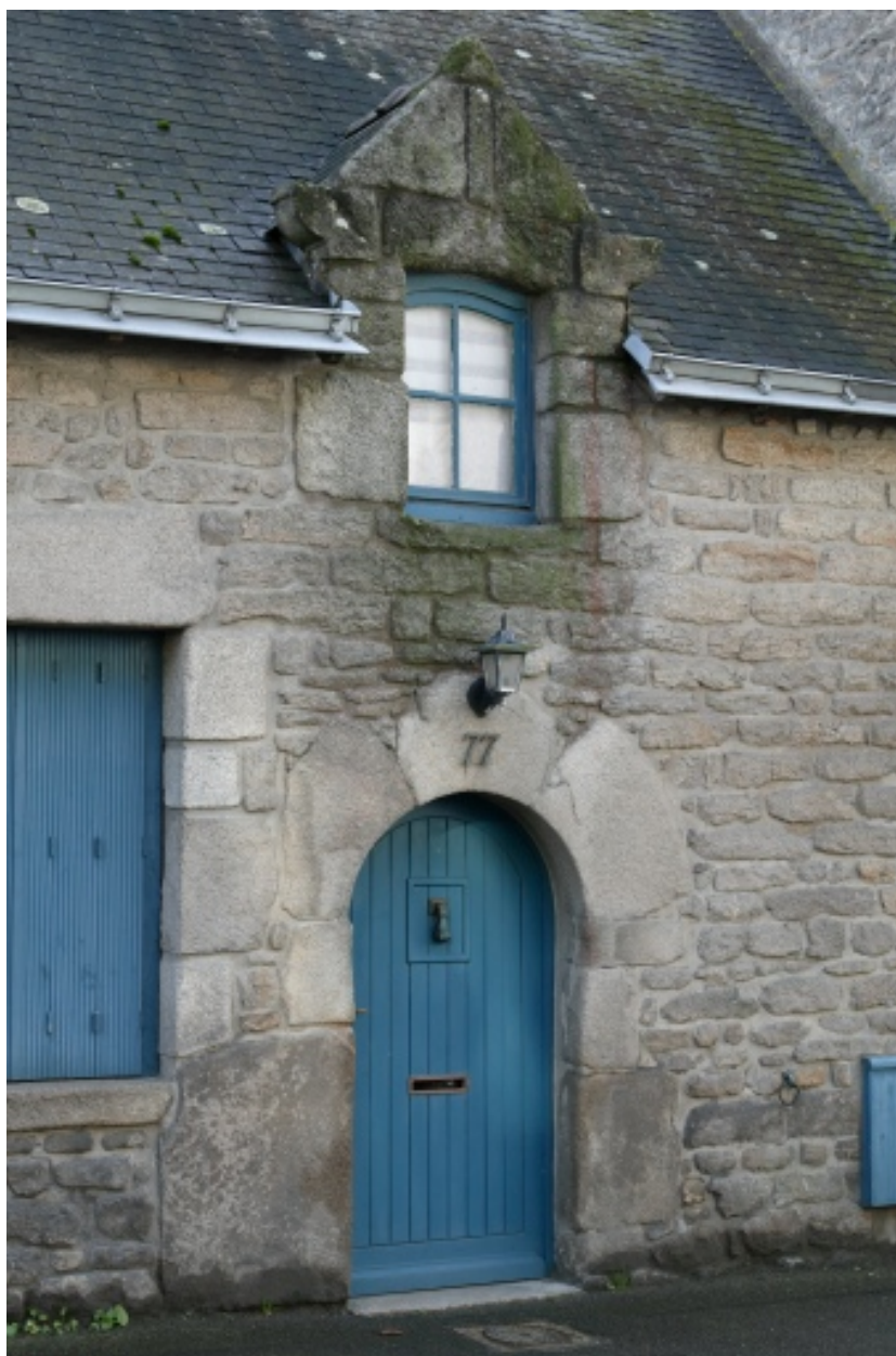
Façade sur rue, détail de la travée centrale.
