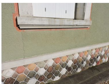
Détail du décor de la façade : enduit, encadrement et appui de baie, solin en parement. Phot. Yannis Suire IVR52_20198503195NUCA
